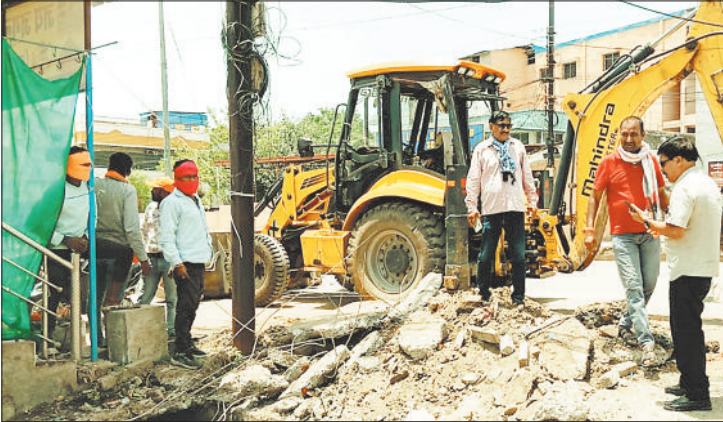
सरकंडा में पाइप लाइन सुधारने पहुंचे नगर निगम के कर्मचारी।
